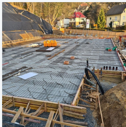
BODENPLATTE, BEWEHRUNG
