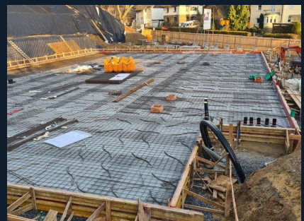
BODENPLATTE, BEWEHRUNG
